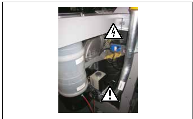
Figura: Transformador de ignición, electrodo de encendido de alta tensión, válvula multigás, control automático de presión de gas, ventilador, cámara de combustión Peligro por tensión eléctrica, peligro de intoxicación y de explosión por fuga de gas, peligro de quemaduras por componentes muy calientes.
